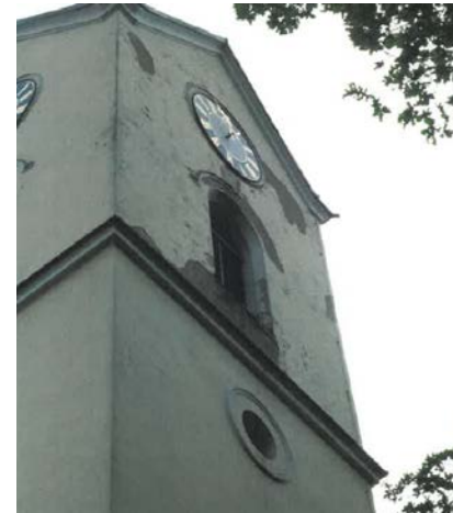
Sanierung Kirche Seyda
